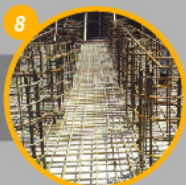
8 띠철근 및 하부근 조립
